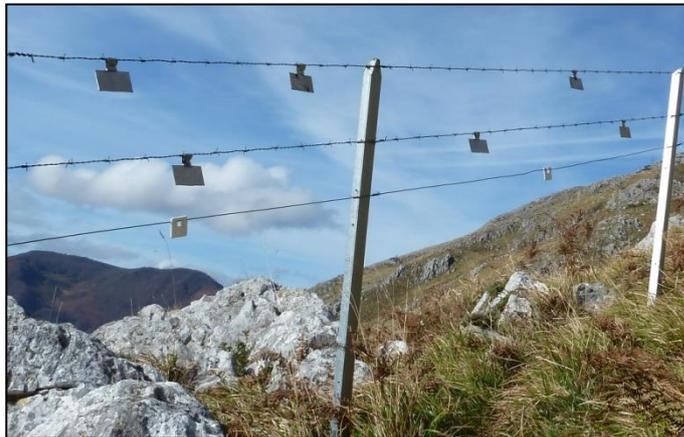
> Clôture visualisée avec des plaquettes aluminium
